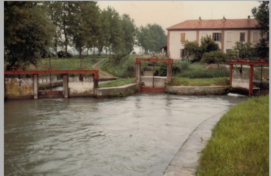
水田への用水路と分水堰。ミラノ近郊。 ポー河より導水。
